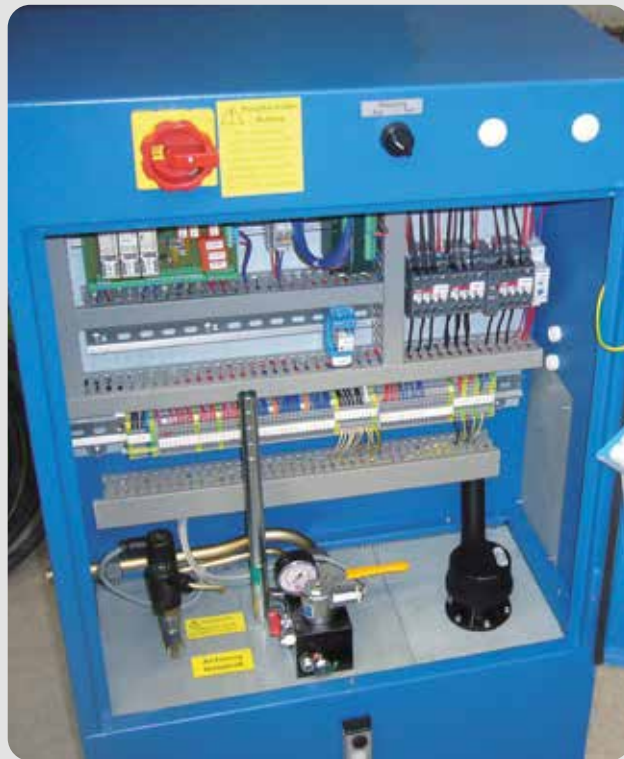
Geöffneter Steuerungsschrank, im unteren Bereich von links nach rechts Druckschalter, Steuerblock und Einfüllstutzen, in der Mitte die Steuerung, oben links der Hauptschalter
