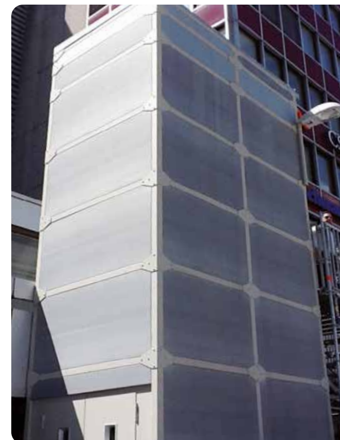
Baufzug Blechketten aus verzinktem Blech, Gerüststreben grundiert
